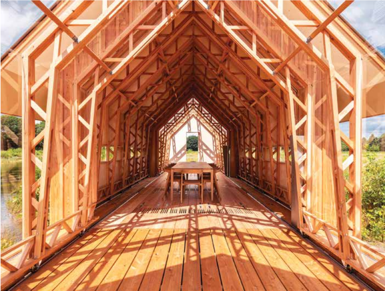
The sturdy construction and materials allow ANNA Stay to last one hundred years. 小屋堅固的木質框架結構持久耐用，可以使用上百年。
